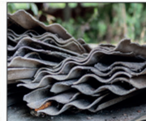
Les plaques de fibrociment ou autre composant contenant de l'amiante.
